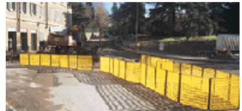
Fasi previste : Infissione paletti nel terreno e sistemazione rete di plastica; preparazione delle buche mediante scavo manuale con badile per porre in opera le colonne di sostegno delle ante dei cancelli e getto del calcestruzzo, previo ancoraggio, con elementi di legno delle colonne stesse. Collocazione su appositi supporti dei cartelli segnalatori con l'uso di chiodi, filo di ferro, ecc.
