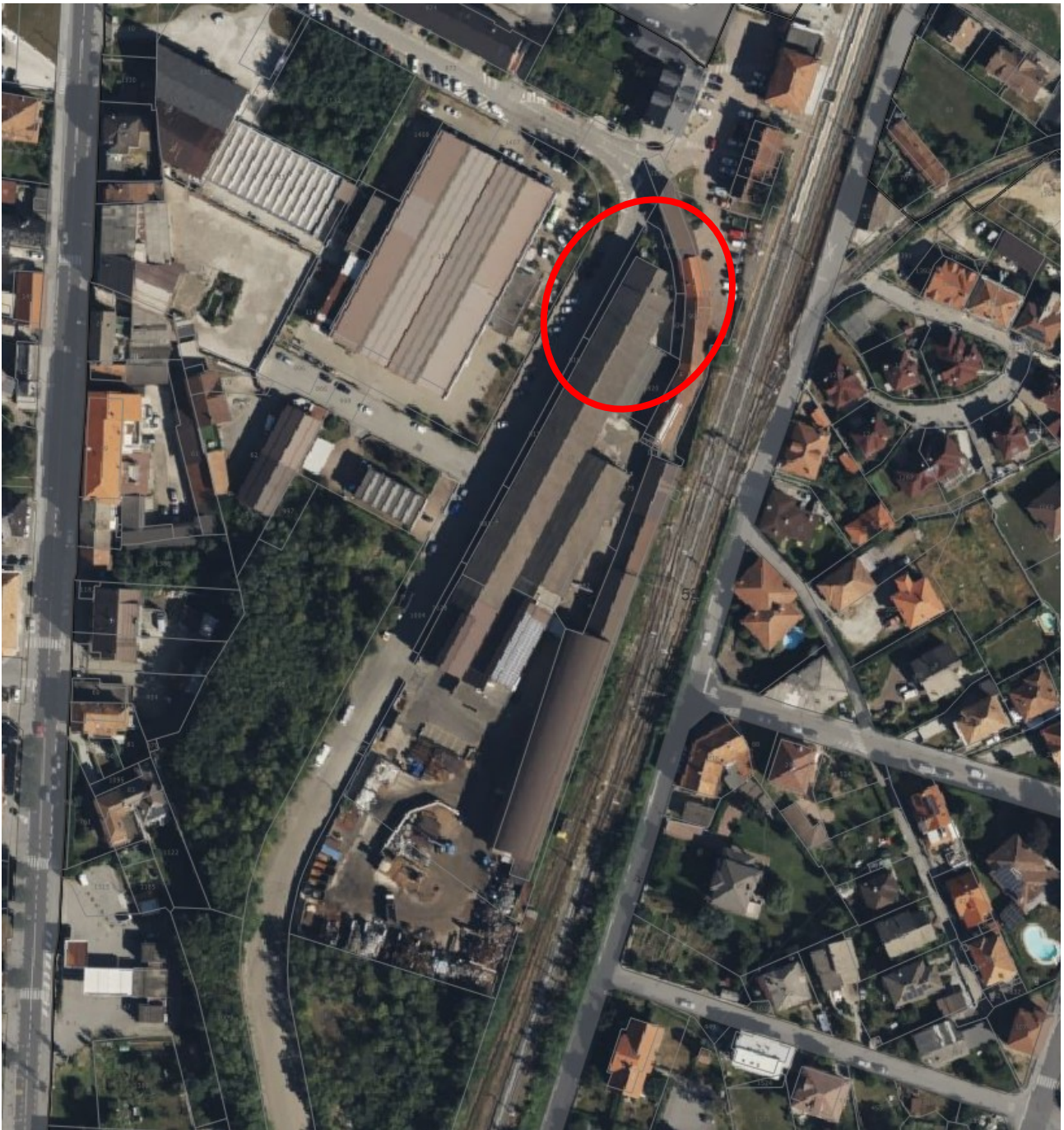
Porzione di capannone di proprietà A.I.B.
