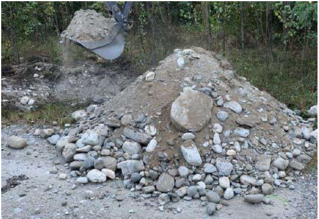
Figura 15: Il materiale proveniente dallo scavo 3
