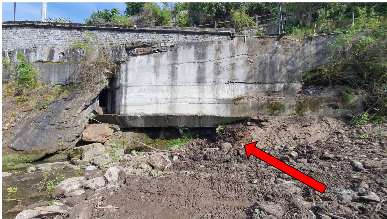
Foto 2 : svuotamento del terreno di fondazione della muratura di sostegno della strada comunale- Intervento
